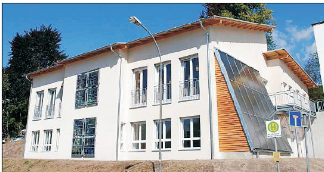
1,8 Millionen Euro haben das neue Pfarrzentrum, der Rückbau der Bibliothek, der neue Heizverbund für das Pfarrhaus und die Umgestaltung der Außenanlagen gekostet. 200 000 Euro davon muss die Pfarrei aus Eigenmitteln finanzieren.
